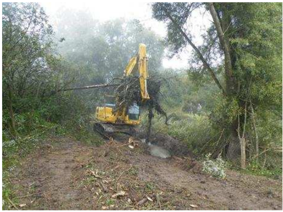
Les travaux sont fidèles à l'état d'esprit du comité de pilotage de Natura 2 000. D.P. (CLP)
